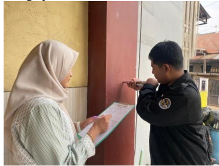
Gambar 3. Pengujian Hammer Test di Lokasi Ponpes 2
