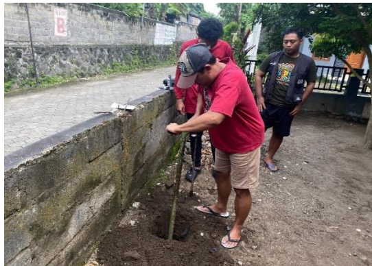
Gambar 2. Praktik Pembuatan Lubang Resapan Biopori
