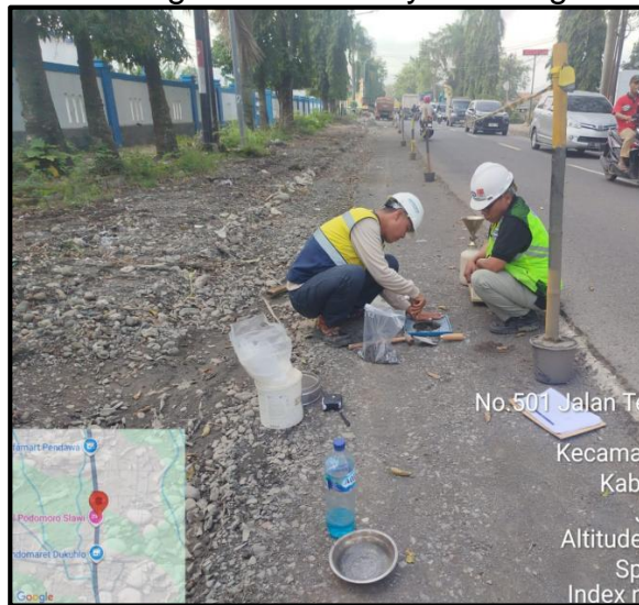
Gambar 3. Proses Penutupan Lubang Pengujian
