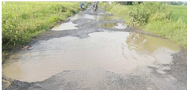
Gambar 3 Kondisi jalur evakuasi tsunami di Desa Pegadungan
