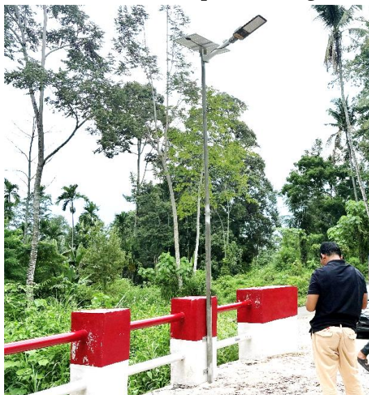
Gambar 2. Kondisi Setelah Pemasangan Solar Street Lighting
