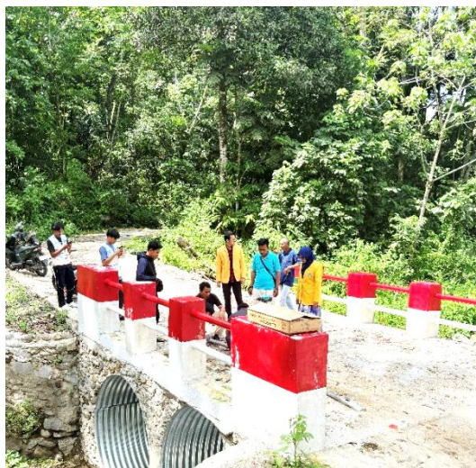
Gambar 1. Kondisi Awal Jembatan Tanpa Penerangan Teknologi Tepat Guna
